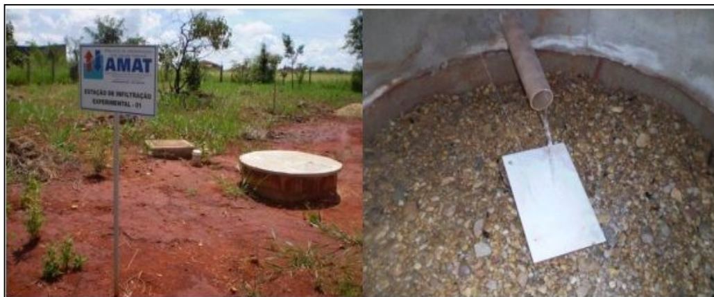
Figura 17: Poços rasos preenchidos com material granular, submetidos a ensaios preliminares com injeções de água. Estação experimental do Sistema Piloto de Recarga Artificial.
