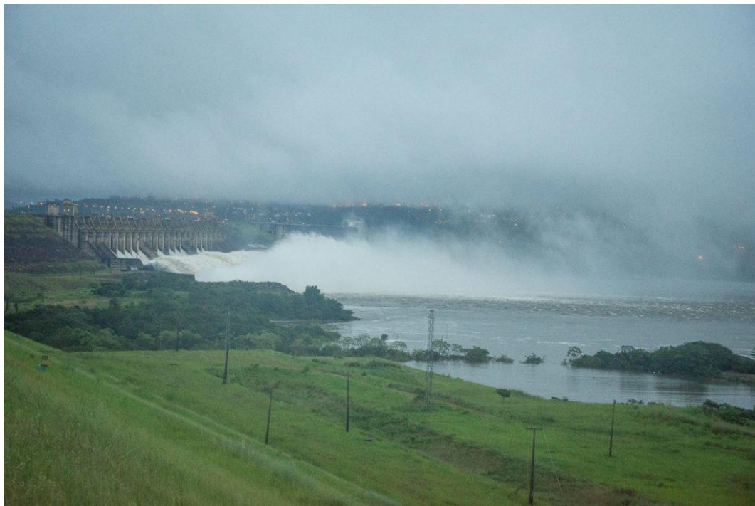
Usina Hidrelétrica de Tucuruí (Foto: Pedrosa Neto/Amazônia Real)
