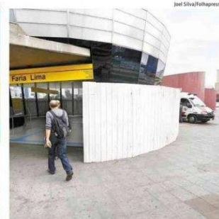
Tapumes protegem entrada de estação do metrô em SP
