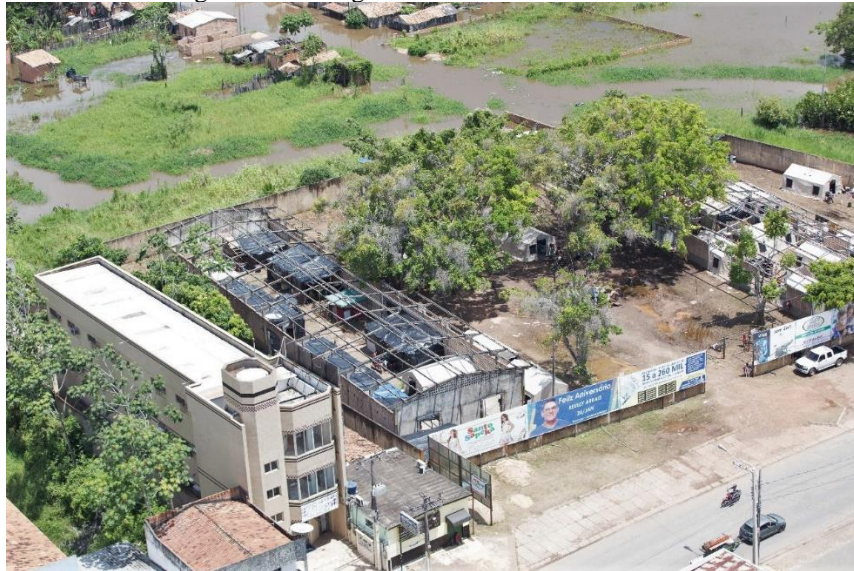
Figura 16 – Abrigos construídos na ZAC VM04.
