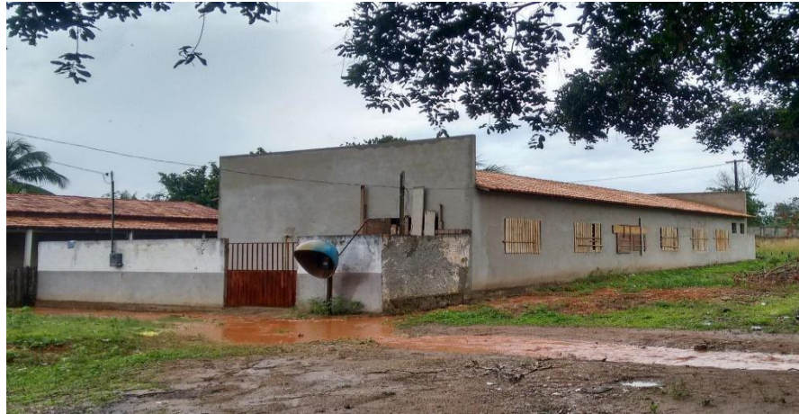
Figura 11 - Reforma do Posto de Saúde da Comunidade
