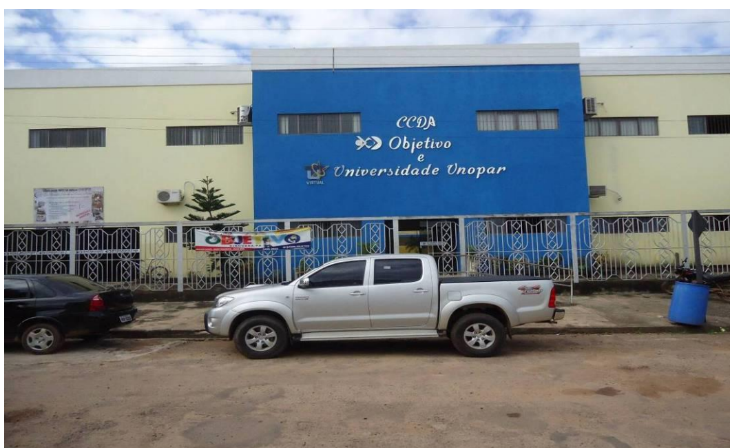
Fig. 7 – Fachada do CCDA. Fonte: Elaboração do autor
