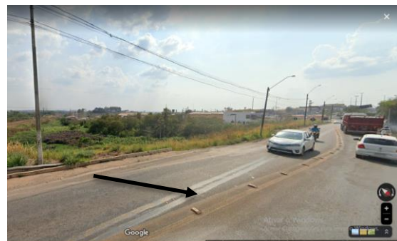
Figura 31 - Finalização do desvio da pista de rolamento
