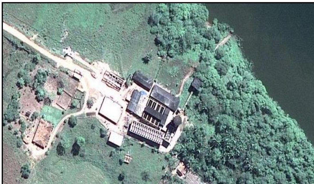
Figura 01: Localização ETA-Nova Marabá-Vista Aérea; Fonte: Google;
