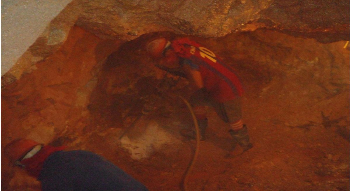
Figura 3: Perfuração da Rocha
