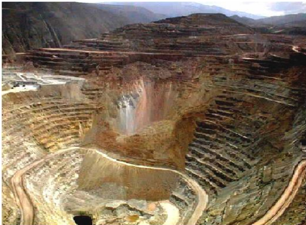
Figura 01 – Desmoronamento em uma mina à céu aberto.
