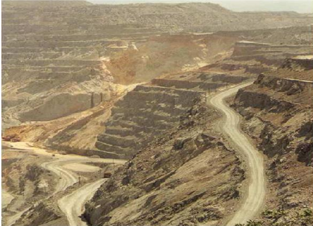
Figura 02 – Desmoronamento em mina a céu aberto.
