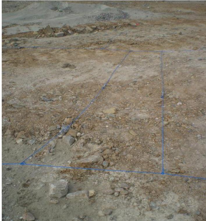
Figura 15. Amarrações entre os furos com cordel detonante.
