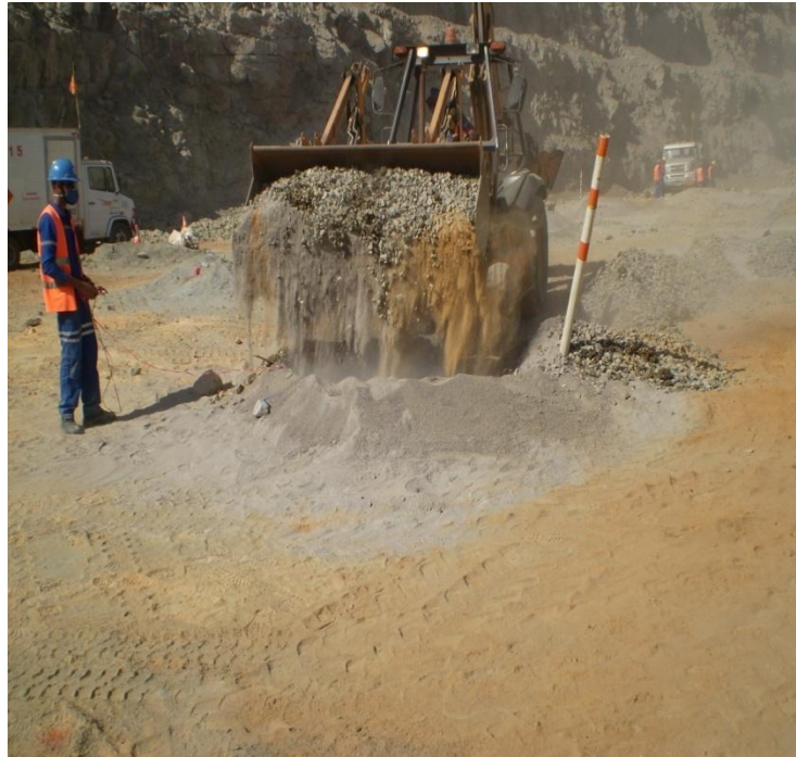
Figura 14. Tamponamento dos furos.
