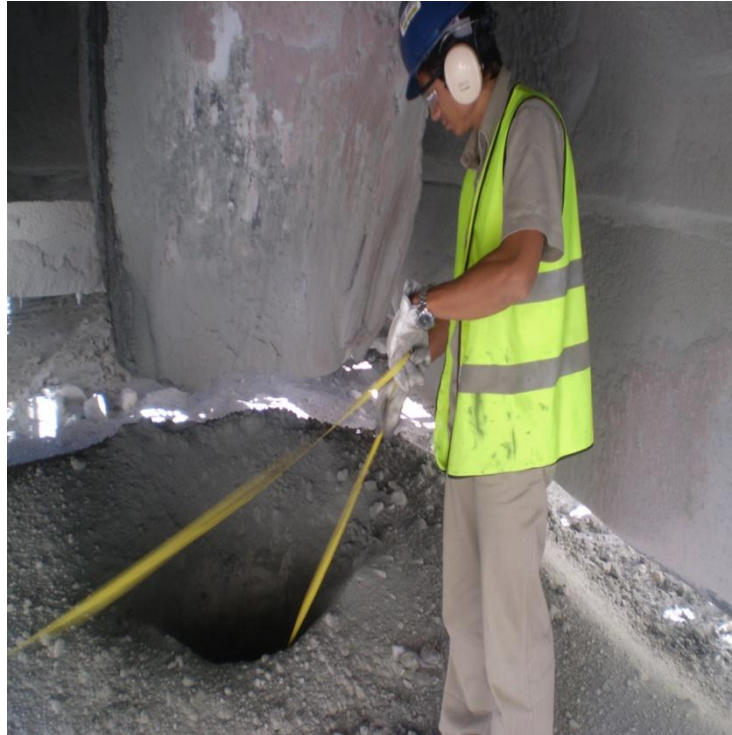
Figura 10. Medição da profundidade do furo (Pr).
