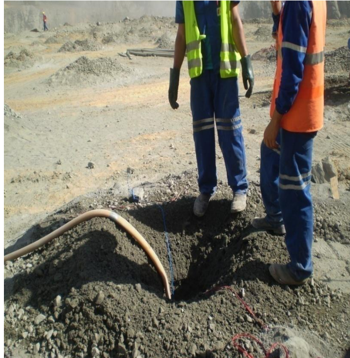
Figura 13. Carregamento dos furos com explosivo.
