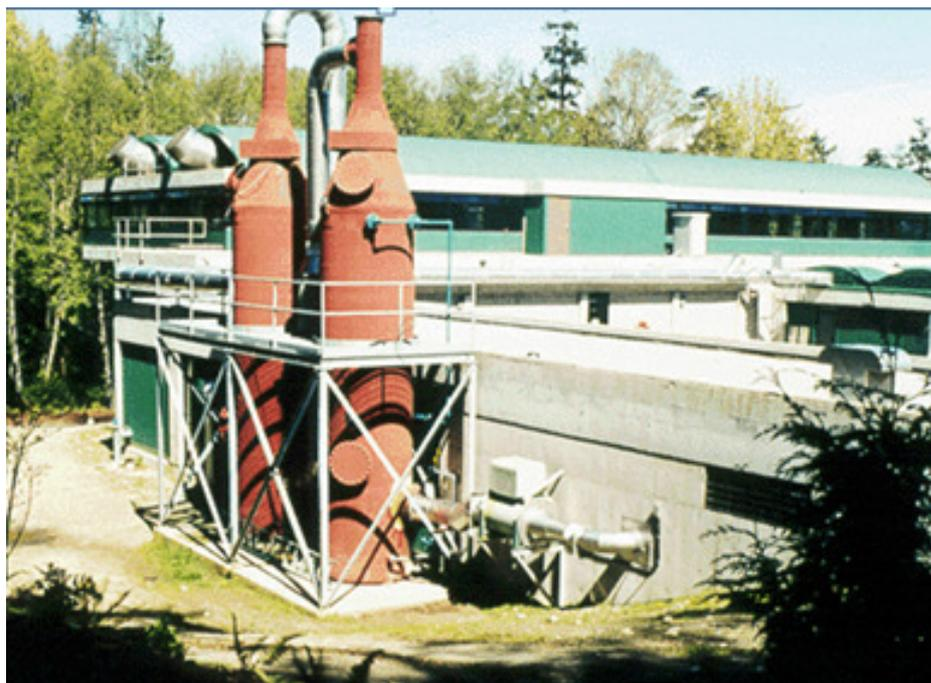
Foto 14 – Coletores Úmidos ou Lavadores de Gás. Fonte: Modulo IV – Equipamentos de Controle de Poluição do Ar. UFES - UNIVERSIDADE FEDERAL DO ESPÍRITO SANTO
