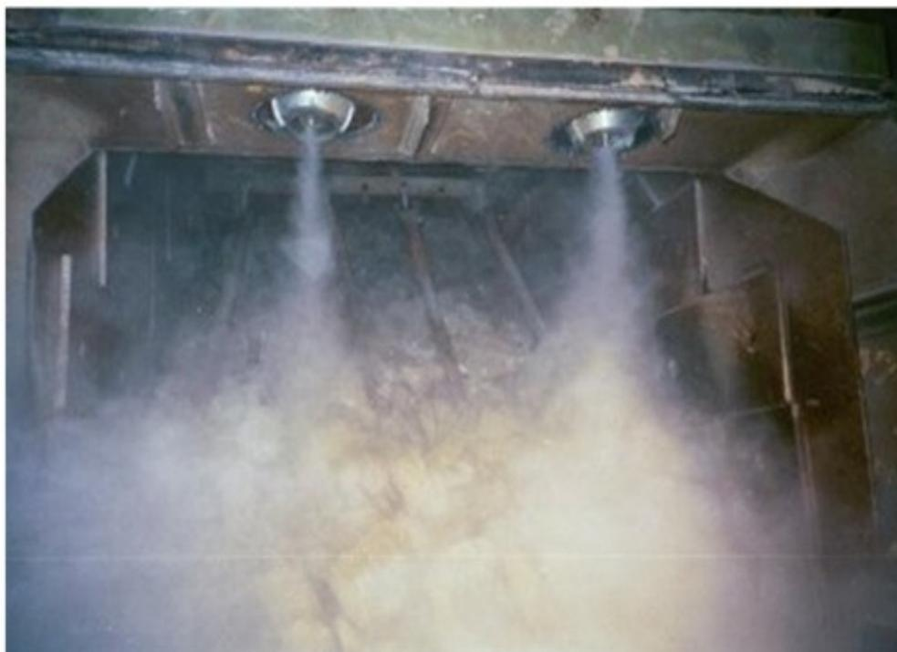
Foto 07 – FOGGER: Vista da névoa dentro de um chute de transferência. Fonte: DSI – Dust Solutions Inc.
