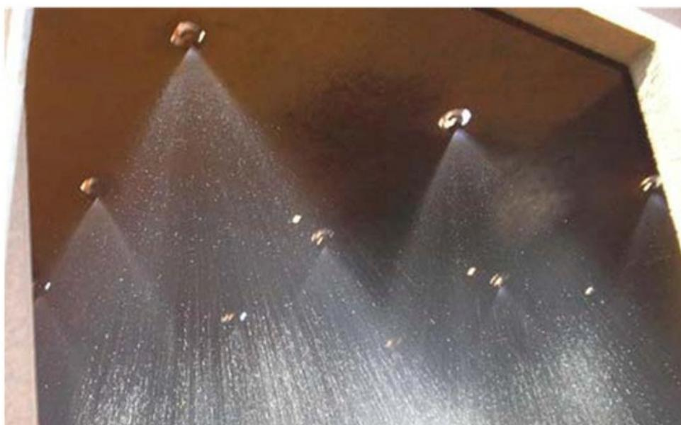
Foto 10 – Aspersor de água para supressão de poeira numa moega. Fonte: PRUNER Automações.
