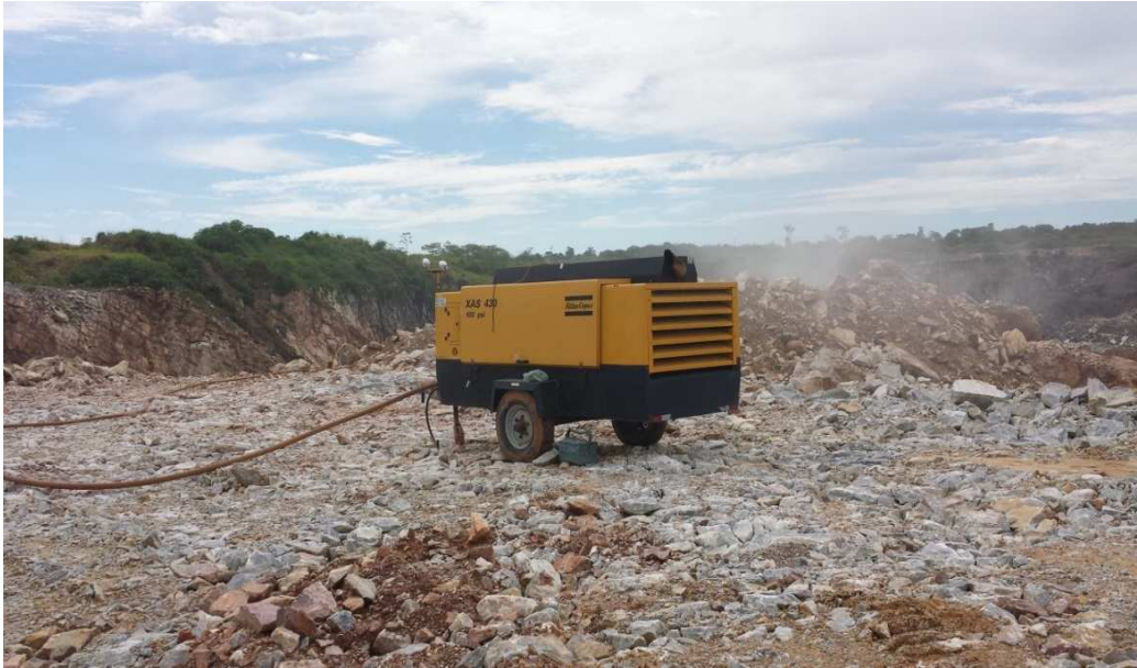
Figura 7- Compressor de ar que fornece energia a perfuratriz. Fonte: arquivo pessoal, 2014.
