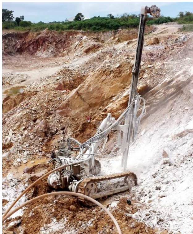
Figura 6- Equipamento de perfuração da empresa Caltins. Fonte: arquivo pessoal, 2014.
