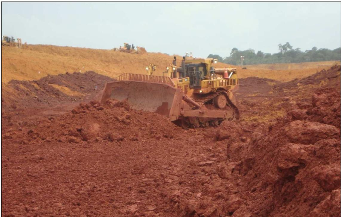
Figura 12 – Trator de esteiras CAT D11T realizando desmonte mecânico (escarificação).
