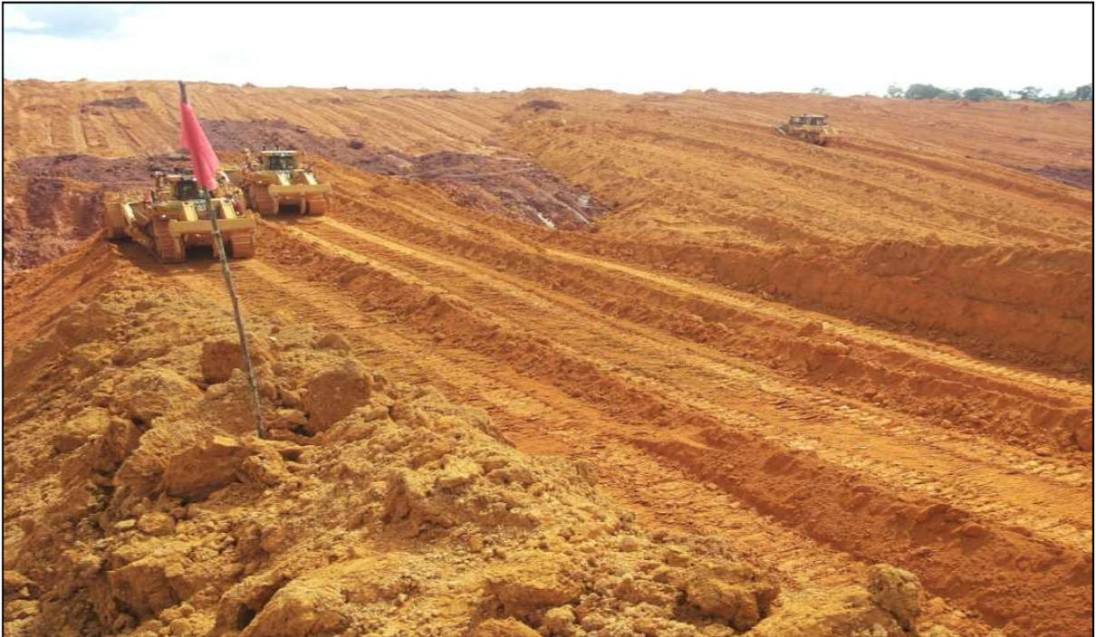
Figura 22 – Marcações topográficas de apoio aos operadores para realização dos testes.
