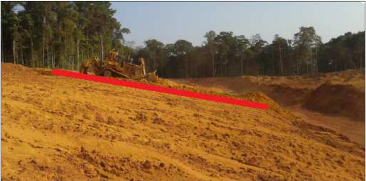
Figura 20 – Trator de esteiras D11 executando decapeamento através do método tradicional.
