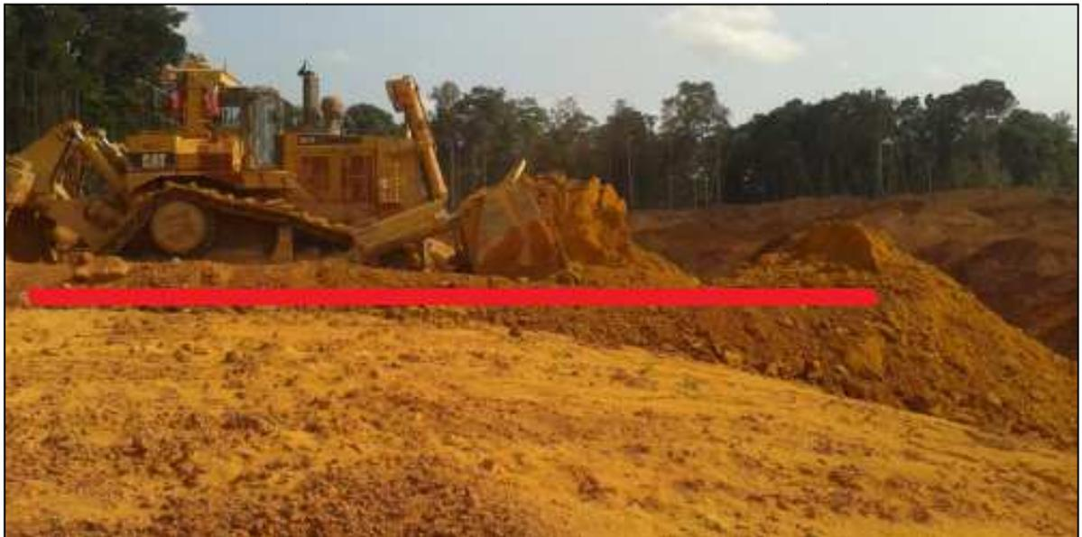
Figura 21 – Trator de esteiras D11 executando decapeamento através do método *wave*.
