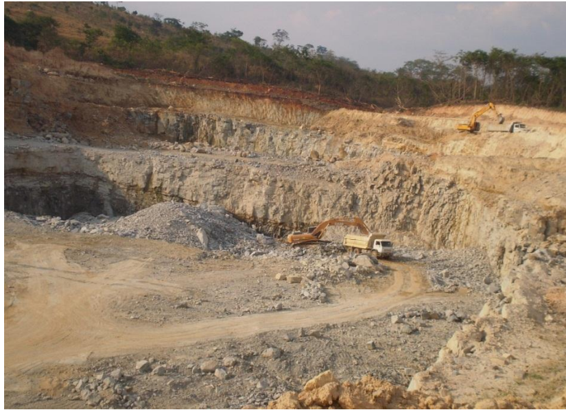
FIGURA 8 - Foto com detalhe da frente de lavra e decapeamento, Pedreira BMS.
