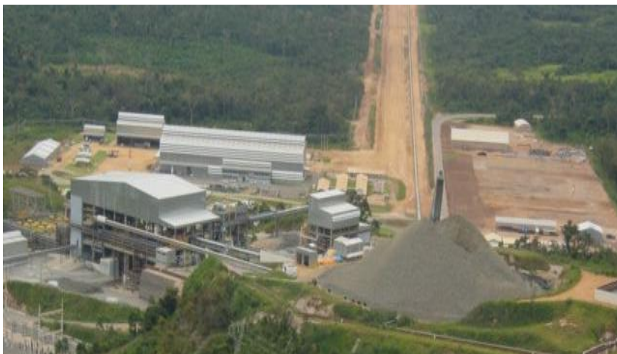
Figura 6. Vista aérea da usina de beneficiamento do Sossego. Fonte: Empresa Vale S/A (2007).
