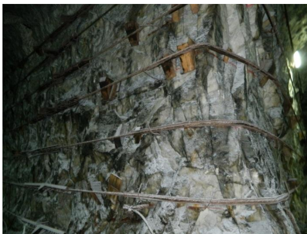
Figura 23 – Cinturão de aço para reforço do pilar.
