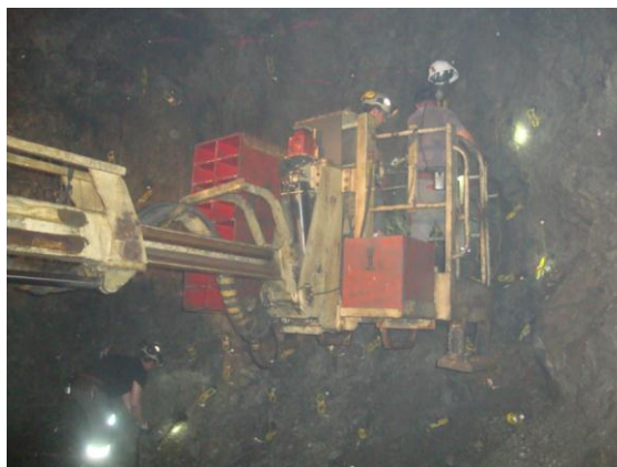
Figura 21 - Serviço de conexão dos detonadores
