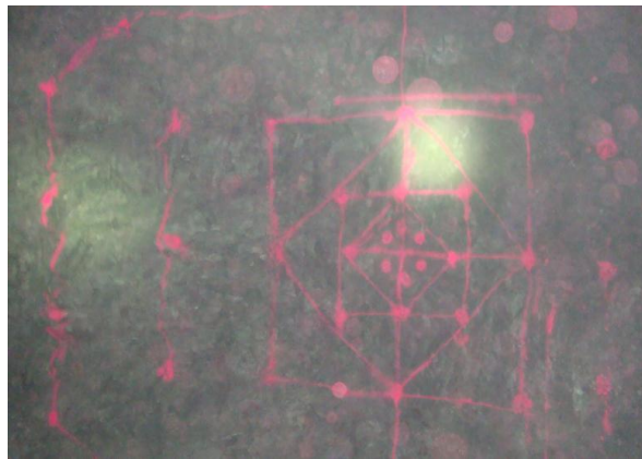
Figura 19 – Marcação de esquema de furos para execução.
