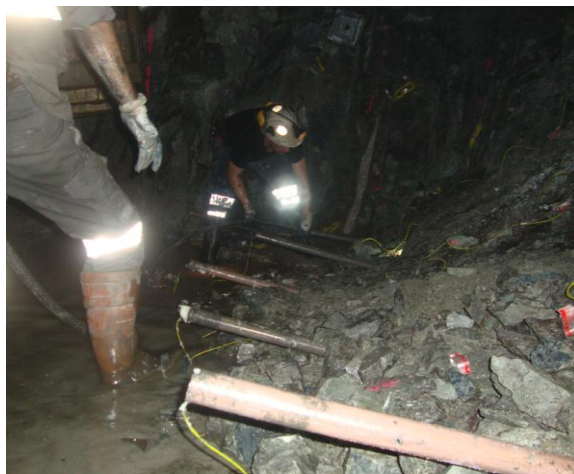
Figura 22 - Operação de carregamento dos furos de levante
