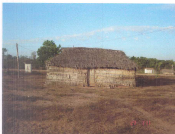
Foto 16 - Algumas das casas da aldeia feitas com palha de babaçu. (teto e paredes).
