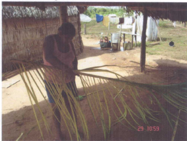
Foto 15 - Preparo da folha do babaçu para a cobertura da casa. Foto: Marlon Prado- 29/06/2006.
