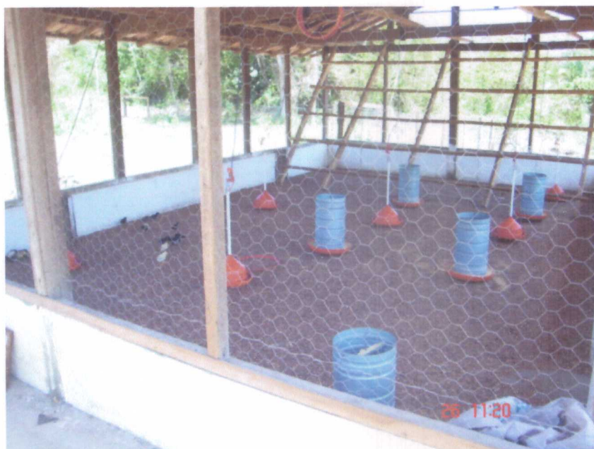
Foto 3 - Estrutura do aviário dos Suruí
