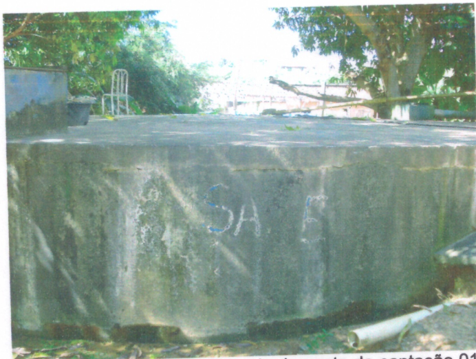
Foto 03 – Reservatório Elevado do posto de captação 01.
