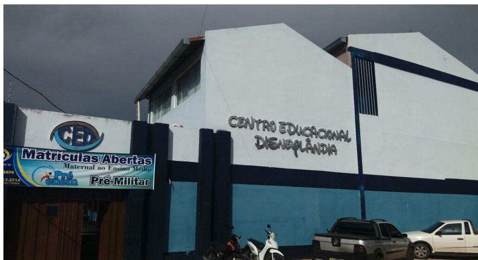
Figura 01. Centro Educacional Disneylândia.
