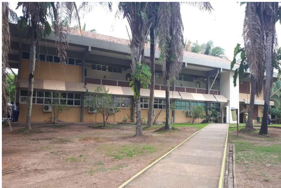
Figura 18 - Visão geral do Prédio do ICE.
