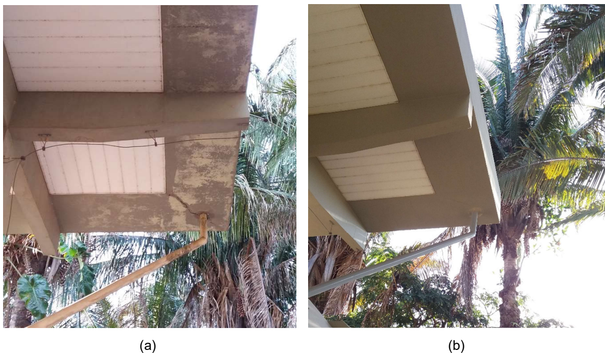
Figura 45 - Cobertura do prédio do ICE: (a) antes da pintura; (b) após a pintura.
