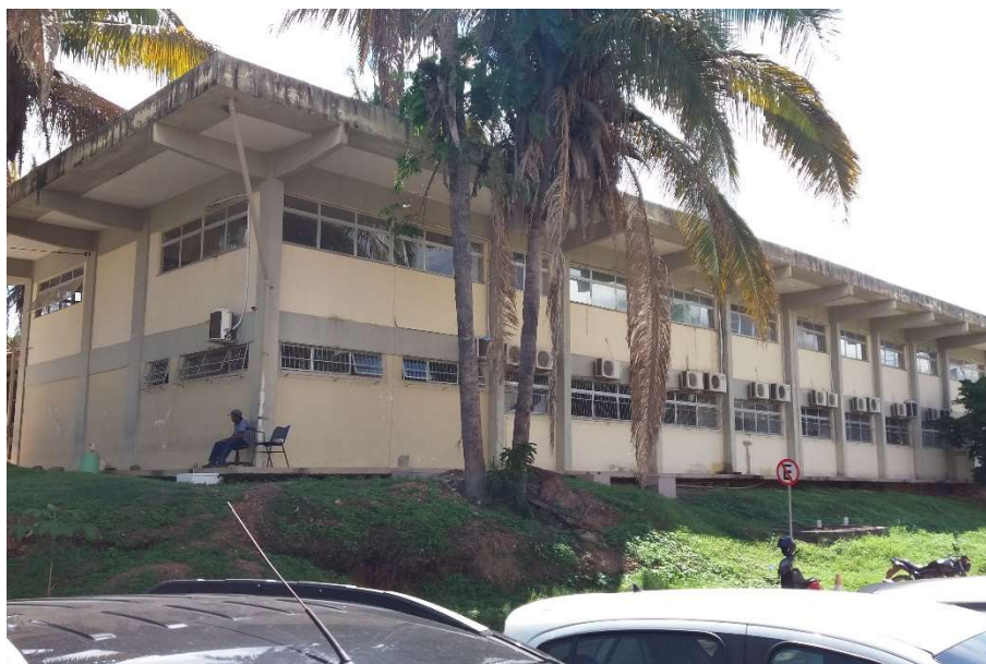
Figura 19 - Visão geral do Prédio da FAGEO.
