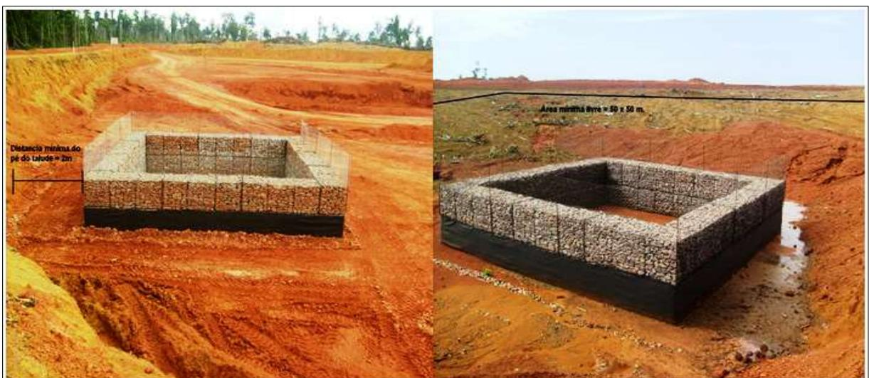
**Figura 27** - Gabião, evidenciando a distância mínima do pé do talude do acesso de contorno até o gabião e a localização do gabião na bacia de contenção de sólidos/amortecimento
