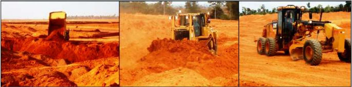
**Figura 37** - Atividade de regularização do depósito.
