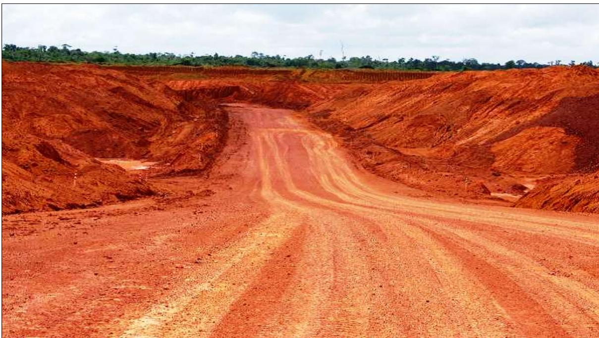
**Figura 18** - Rampa com 8% de inclinação.
