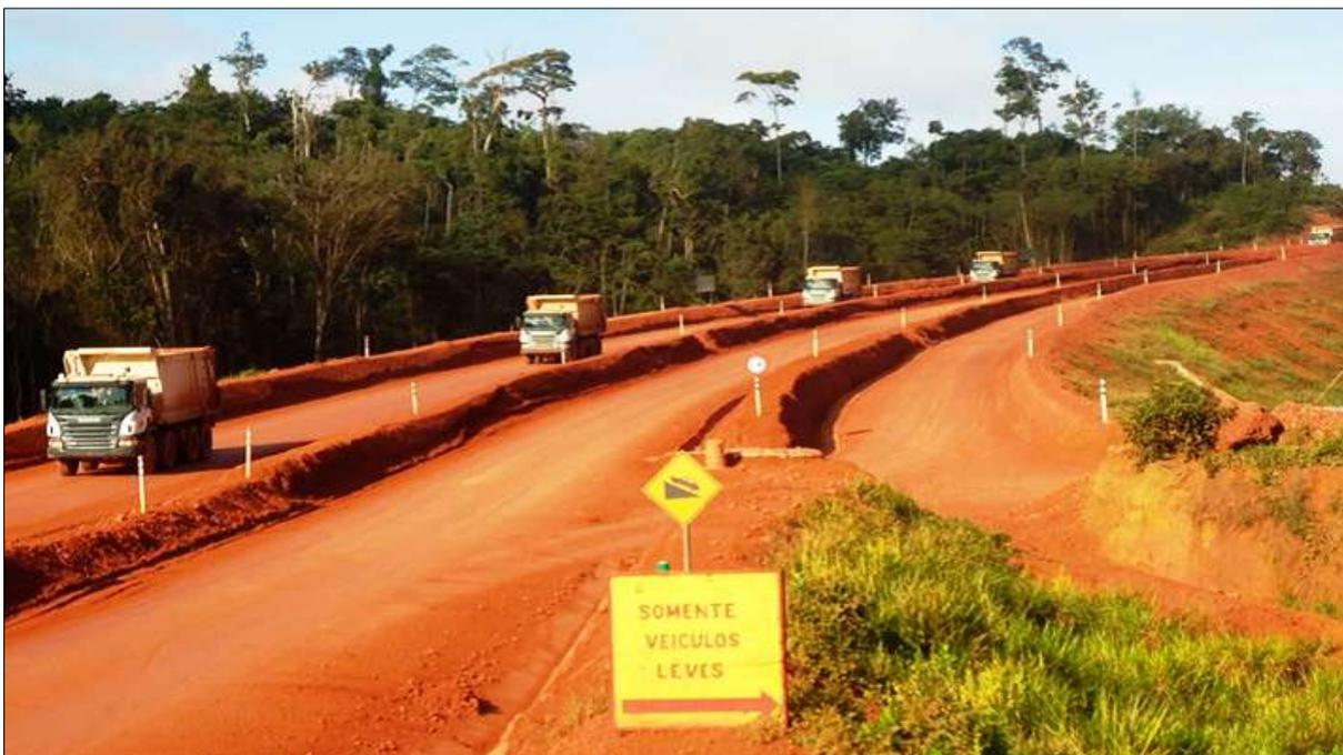
**Figura 16** - Transporte do minério a britagem primária por caminhões Scanea P420 25m<sup>3</sup>
