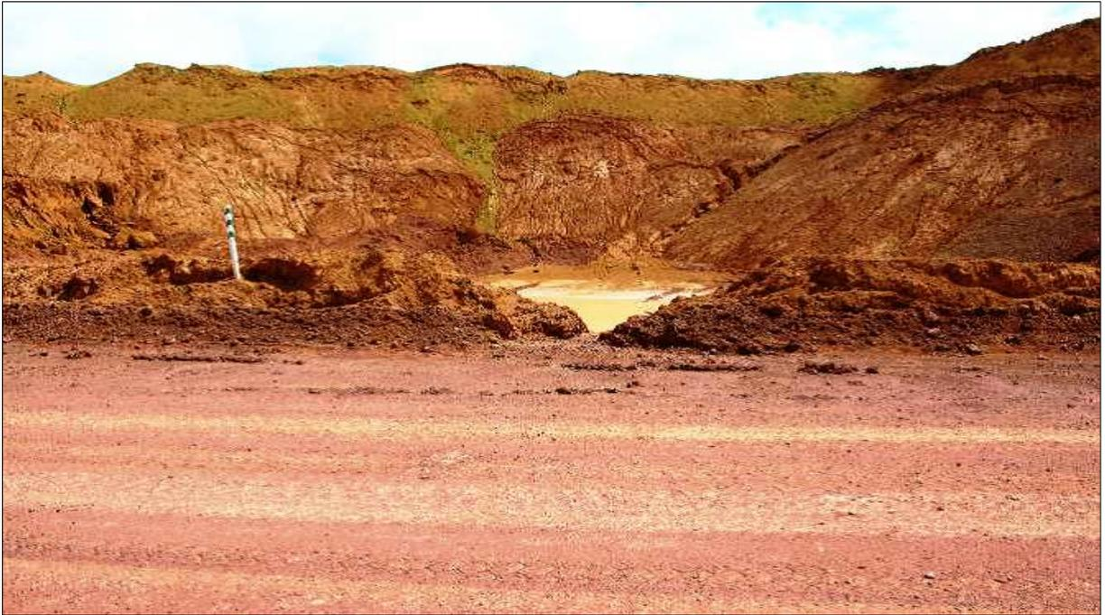
**Figura 34** - *Sump* com profundidade mínima de 2,5m.
