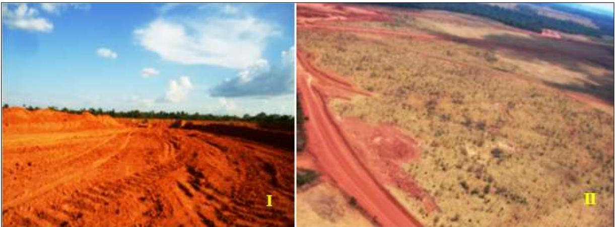
**Figura 38** - Processo de regularização do depósito: I nivelamento do depósito e II terreno nivelado apto a receber a vegetação.
