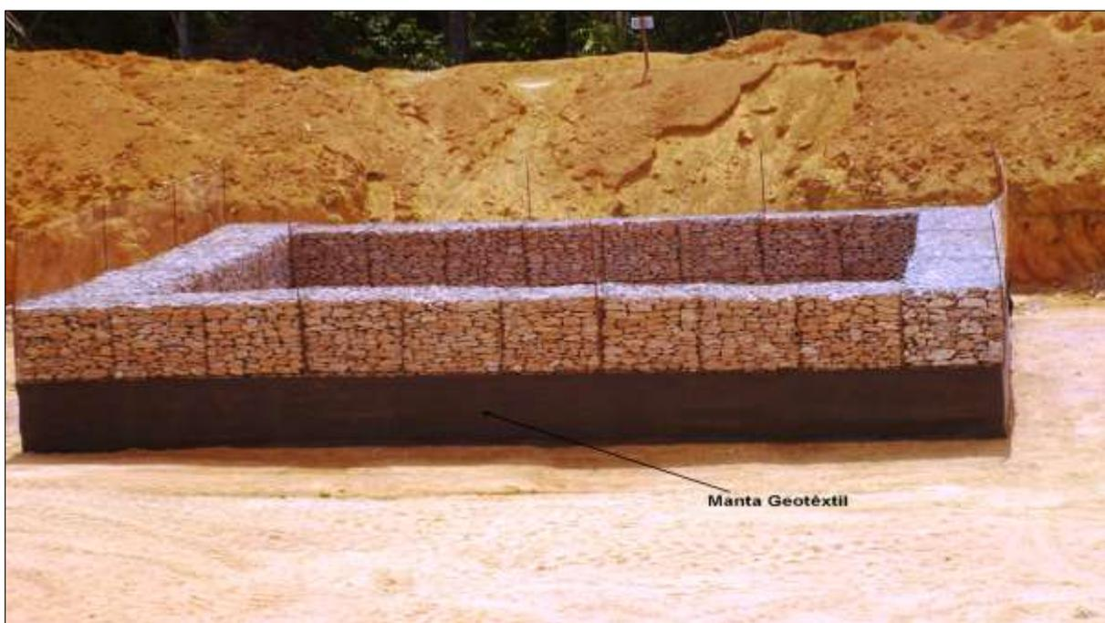
**Figura 29** - Gabião revestido com manta geotêxtil.
