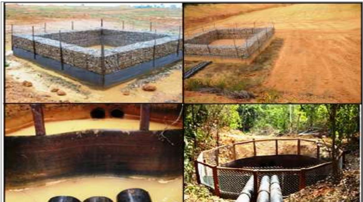
**Figura 28** - Sistemas extravasores de gabião e bacias de dissipação de energia cinética.
