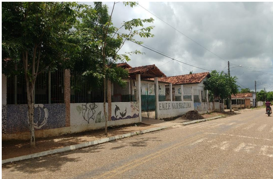
Figura 09- Fachada Escola Municipal de Ensino Fundamental Nair Braz Lima
