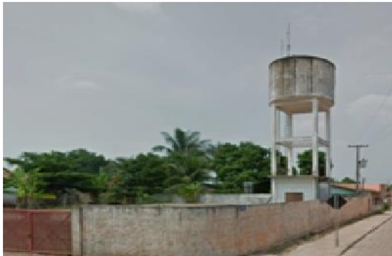
Figura 4 - Sistema de Abastecimento de Água Sede do Município 1, Rua Cachoeira do Couto.
