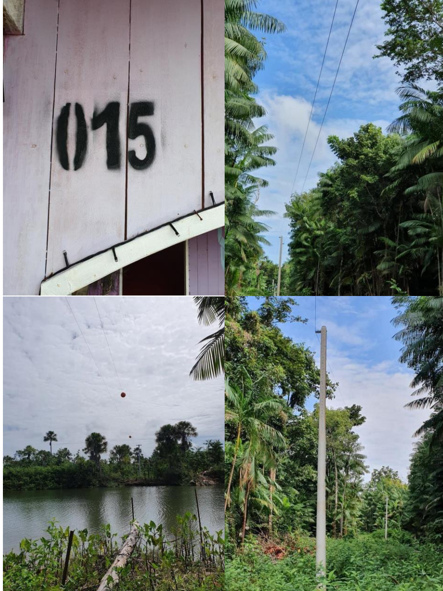
Figura 25 - Imagem de elementos da energia elétrica na comunidade
