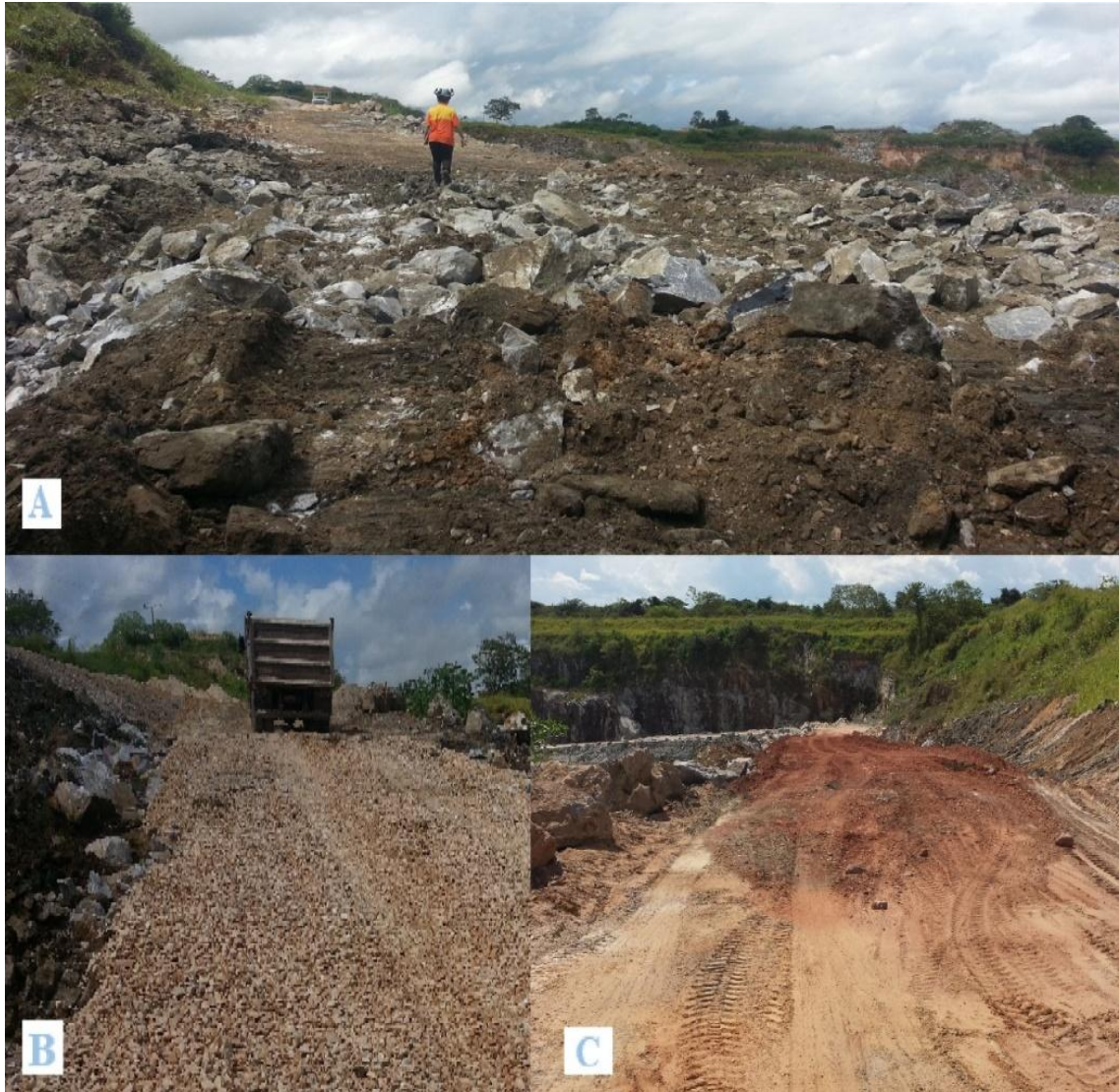
Fotografia 5 - Camadas de estruturas. A) Camada sub-leito. B) Camada de base. C) Camada de revestimento.
