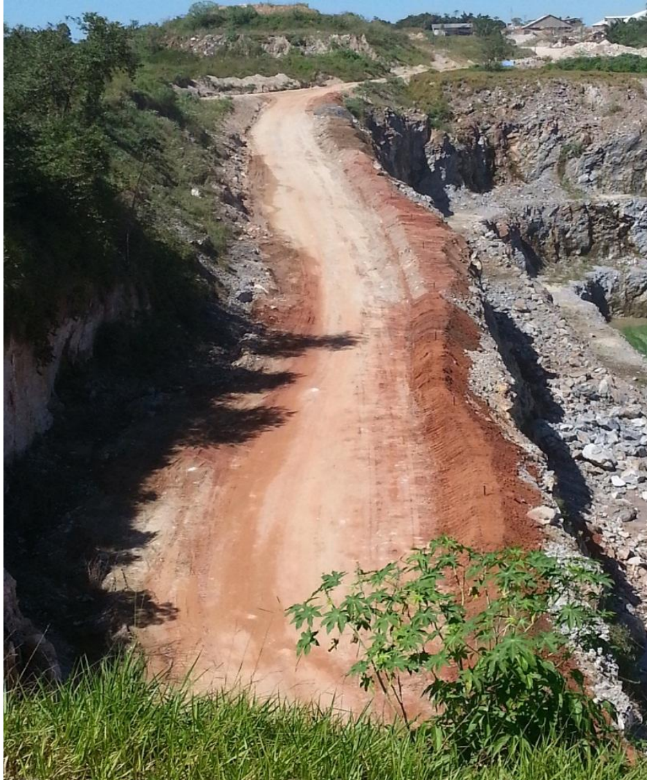
Fotografia 9 - Rampa de Acesso Principal Finalizada, vista de cima. Fonte: Acervo Pessoal.
