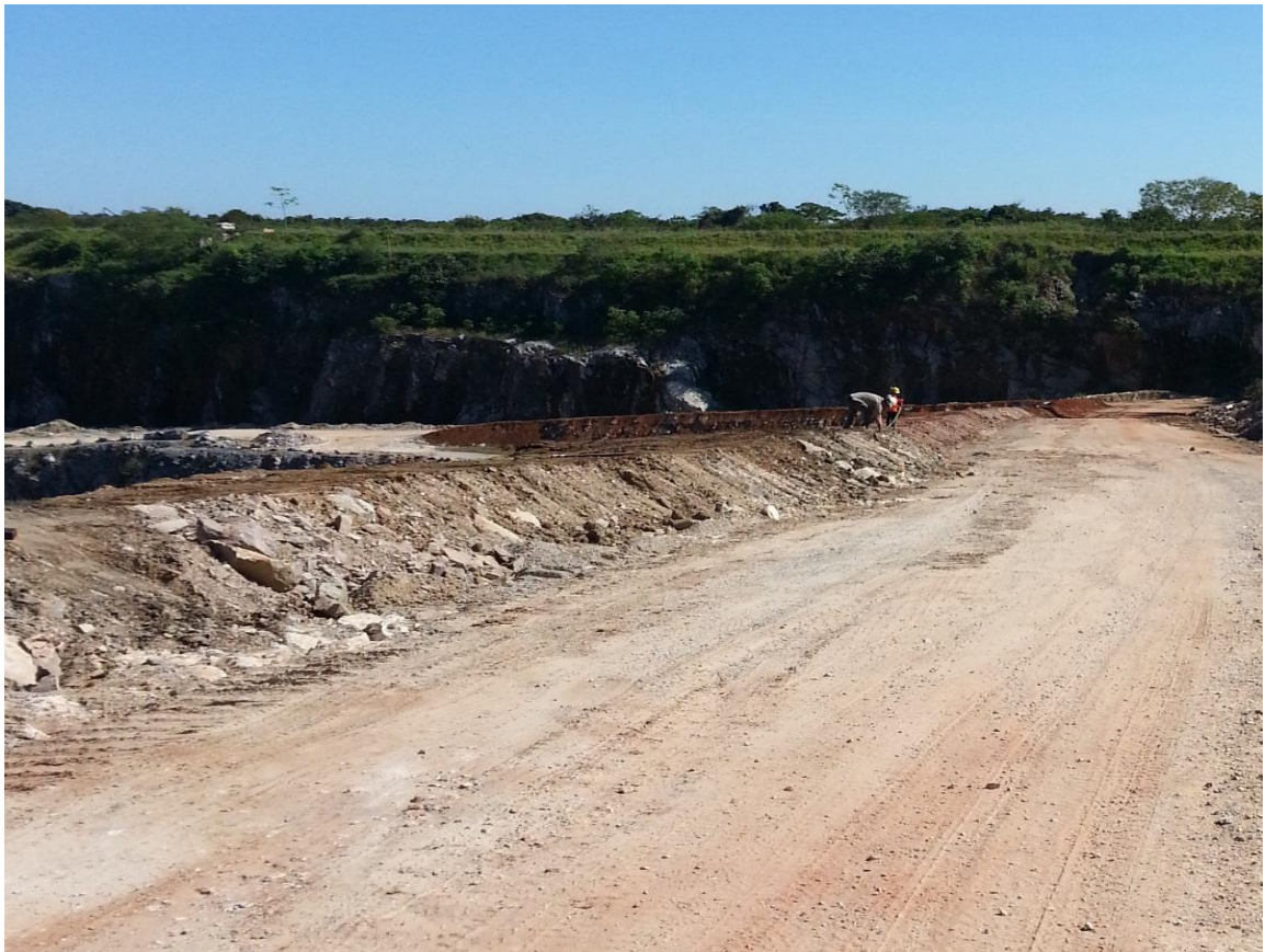
Fotografia 8 - Leira de proteção com 1,40 metro de altura. Fonte: Acervo Pessoal
