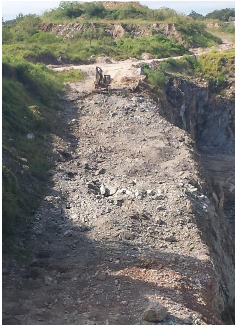
Fotografia 4 - Rampa após detonação. Fonte: Acervo Pessoal (2014)
