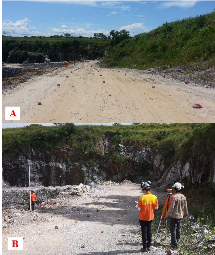
Fotografia 3 - Processos do Plano de Fogo. A) Furos demarcados. B) Nivelamento topográfico dos furos.
