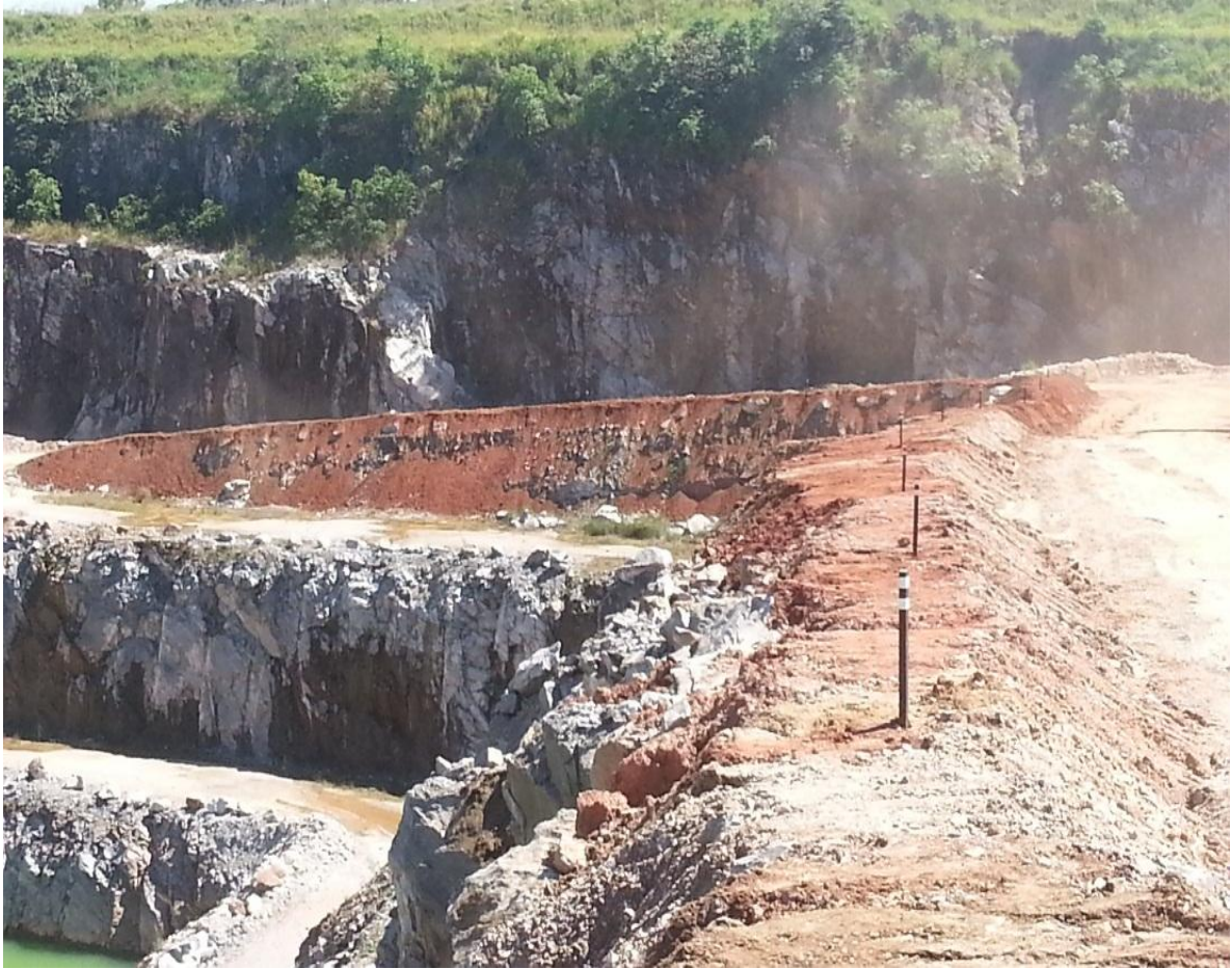
Fotografia 10 - Demarcadores de limite externo de bancada, espaçados em 15 metros. Fonte: Acervo Pessoal
