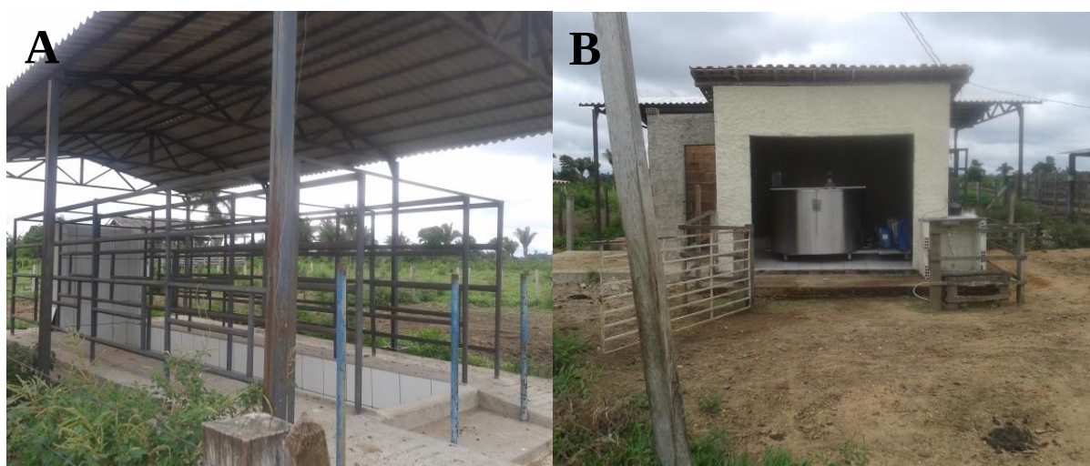
Figura 11. (A) Barracão de ordenha em construção (B) Tanque de expansão em um dos lotes estudados do P.A Alegria, Marabá – PA.
