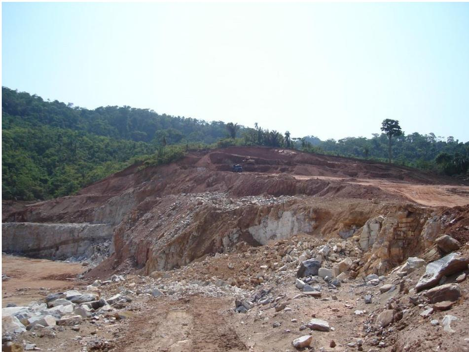
Figura 6: Vista parcial da lavra por bancada realizada na mina (Fonte: Arquivo Pessoal)
